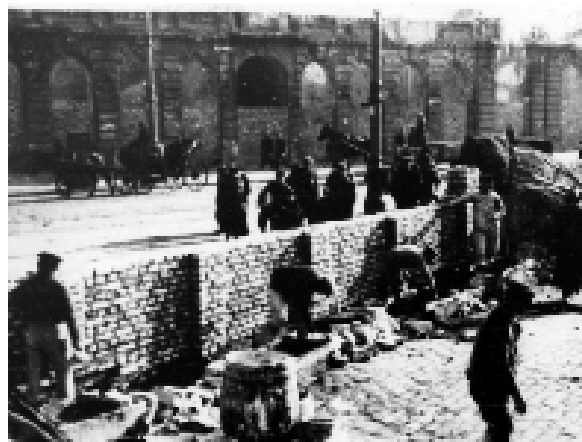
A gettó falának építése a Graniczna utcában (1940)
