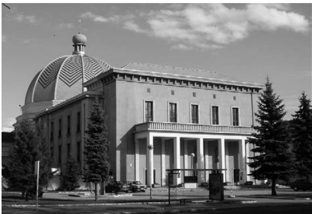
A kassai zsinagóga mai homlokzata
